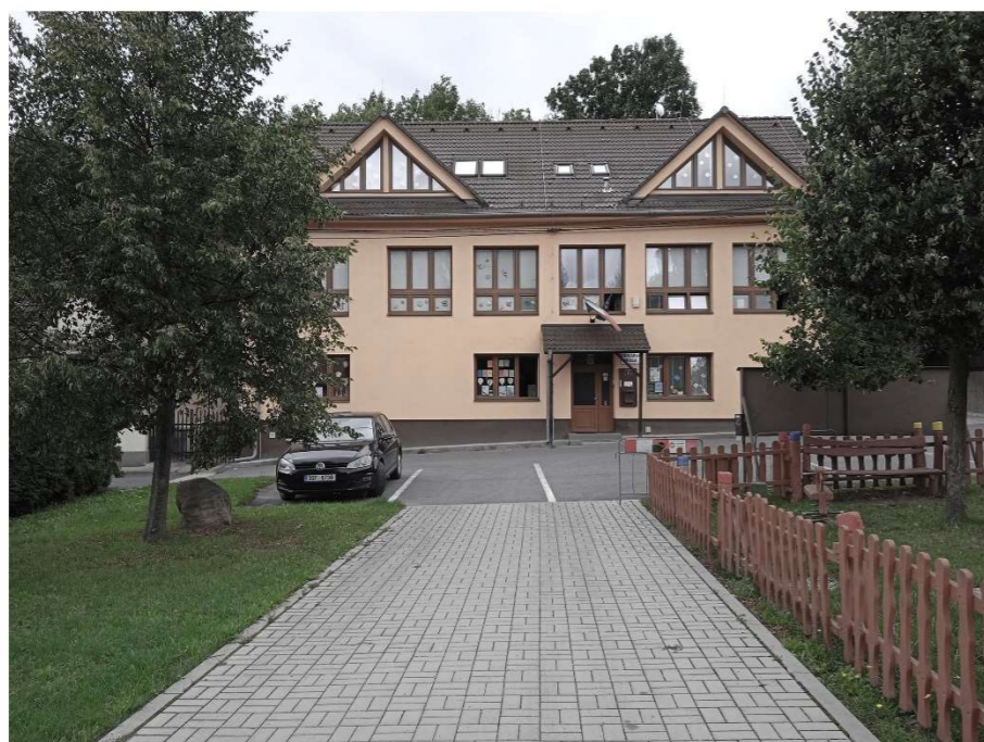
POHLED NA STÁVAJÍCÍ BUDOVU I. STUPNĚ ZŠ V OBCI OHROBEC
