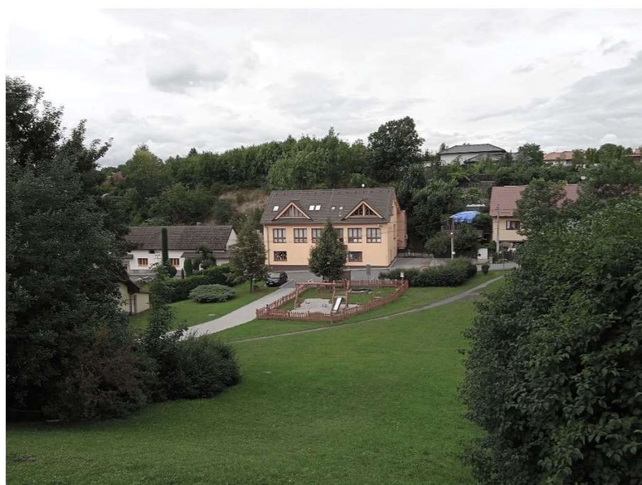
POHLED Z JIŽNÍ STRANY LOKALITY SMĚREM NA STÁVAJÍCÍ BUDOVU I. STUPNĚ
