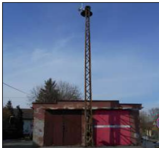
Obr. č. 7: Budova Hasičské zbrojnice
