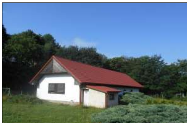
Obr. č. 6: Budova ČOV Ohrobec
